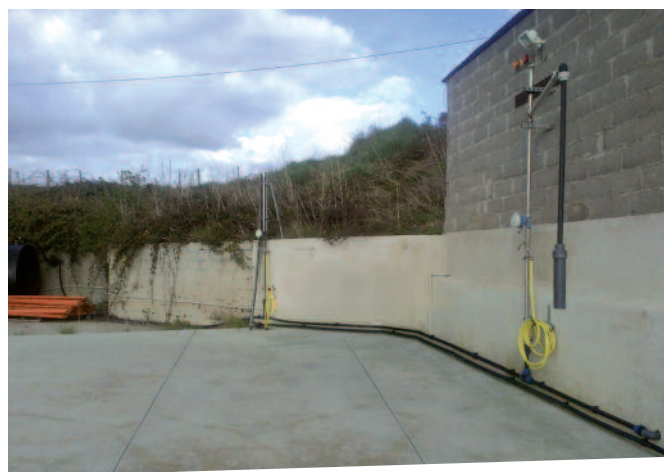
La potence permet un remplissage aisé du pulvérisateur. Le volumètre empêche les débordements.
